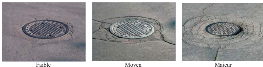
Figure I.19 – Gravité de fissuration autour des regards et des puisards (MTQ-AIMQ 2002).
