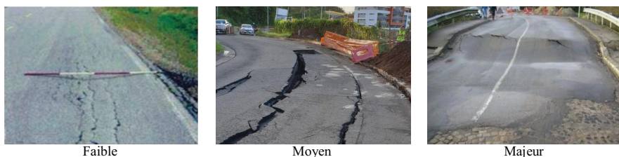
Figure I.4 – Gravité d'un affaissement (Par S. Sihem 2017, Algérie).
