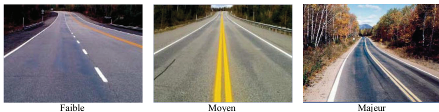
Figure I.16 – Gravité de ressuage (MTQ-AIMQ 2002).
