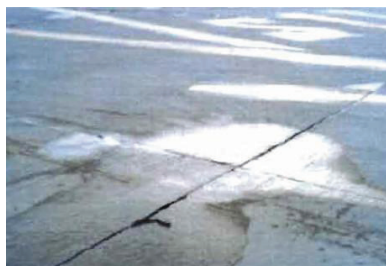
Figure 1.25 – Ejection de matériaux (pompage) en chaussée rigide.
