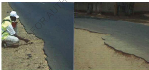
Figure I.23 – Une épaufrure sur une chaussée rigide.
