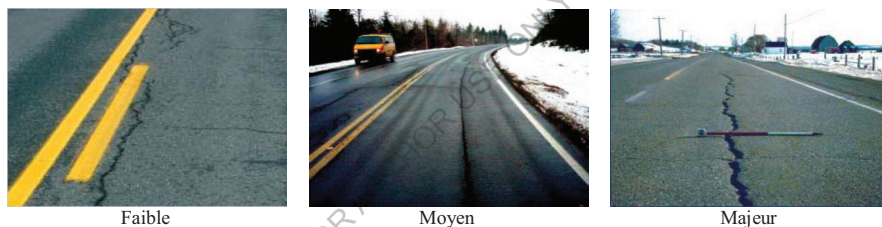
Figure I.9 – Gravité des fissures longitudinales hors piste de roues (MTQ-AIMQ 2002).
