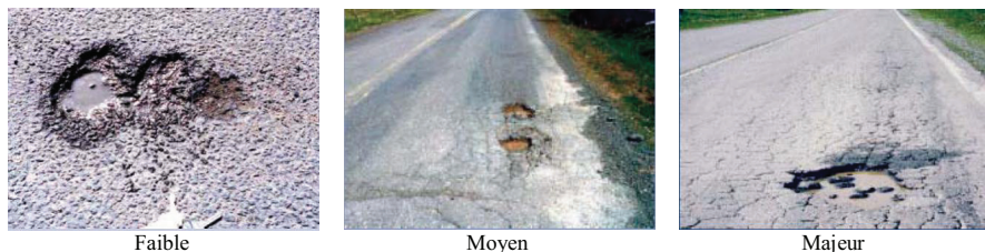
Figure I.15 – Gravité du nid-de-poule (MTQ-AIMQ 2002).
