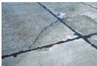
Fissures en coin de dalle
