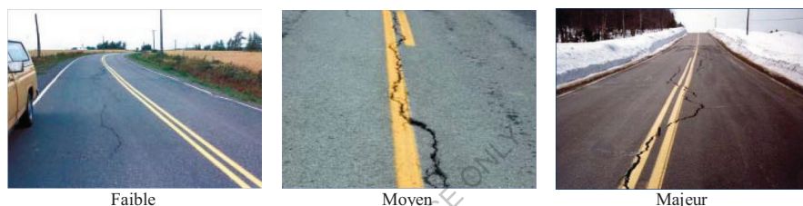
Figure I.10 – Gravité des fissures de gel (MTQ-AIMQ 2002).
