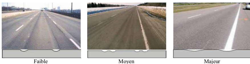
Figure I.2 – Gravité d'une ornière à faible rayon (MTQ-AIMQ 2002).
