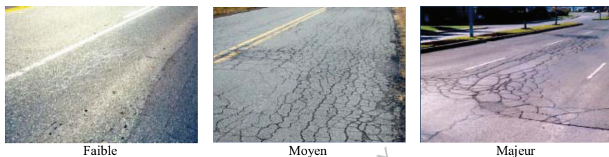
Figure I.11 – Gravité des fissures en carrelage « Faïençage » (MTQ-AIMQ 2002).
