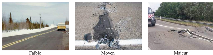
Figure 1.5 – Gravité d'un soulèvement différentiel (MTQ-AIMQ 2002).
