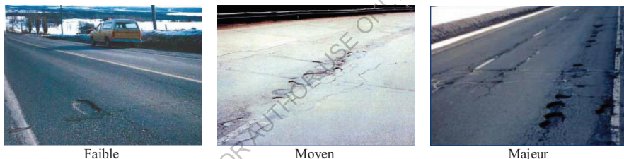
Figure I.14 – Gravité de pelade « arrachement par plaques » (MTQ-AIMQ 2002).
