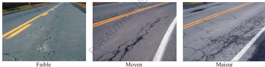
Figure I.8 – Gravité des fissures longitudinales en piste de roues (MTQ-AIMQ 2002).
