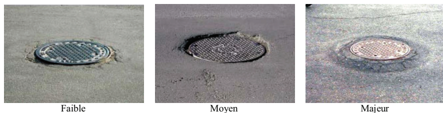
Figure I.20 – Gravité de dénivellation des regards et des puisards (MTQ-AIMQ 2002).
