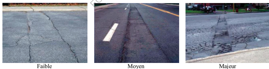
Figure I.21 – Gravité de coupe et tranchée (MTQ-AIMQ 2002).
