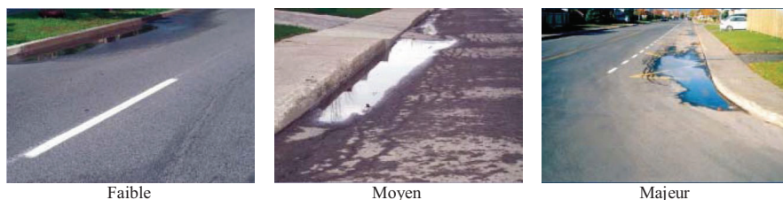
Figure 1.6 – Gravité d'un désordre de profil (MTQ-AIMQ 2002).
