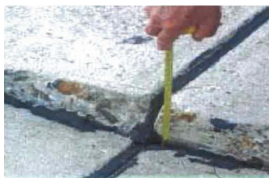
Figure I.24 – Décalage de dalle d'une chaussée rigide.
